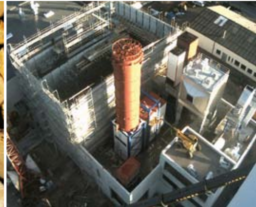
Das Kraftwerk im Bau
